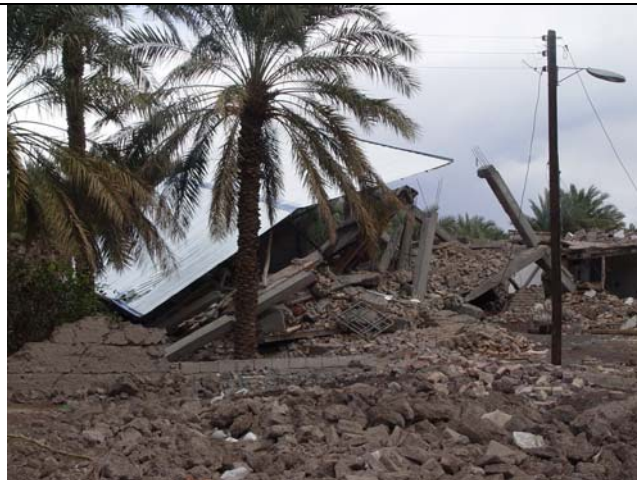
جهت تخریب عمود بر گسل، شرقی - غربی
