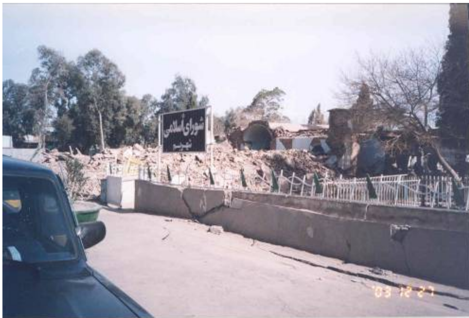
شکل (۳-۱۱): تخریب کامل ساختمان شورای شهر بم
