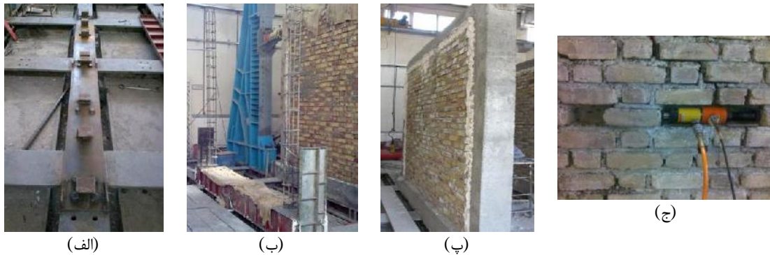
شکل ۳: مراحل ساخت دیوار؛ الف: نصب پلیت کف، ب: نصب کلاف‌های قائم،
