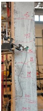
شکل ۱۵: ترک‌های ایجاد شده در کلاف
