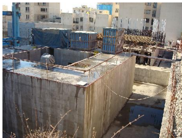
شکل ۳: الف) پی میز لرزان پژوهشگاه ب) دستگاه لرزاننده نصب شده روی پی
