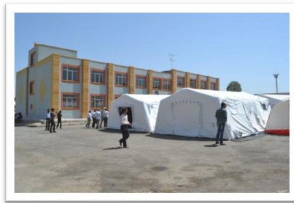
شکل ۳: ساختمان مدارس بهسازی شده و سالم مانده در زمین لرزه اهر-ورزقان (داوودی و دیگران ۱۳۹۱)
